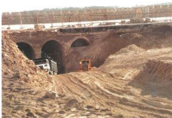
Escavação em frente aos Estábulos de Salomão (1999)
